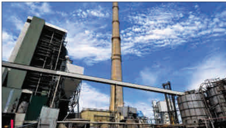
La centrale thermique de Gardanne disposera en 2015 de la plus importante unité utilisant de la biomasse.
