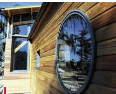
La construction de maisons en bois se développe dans notre région. Mais la filière doit suivre.
